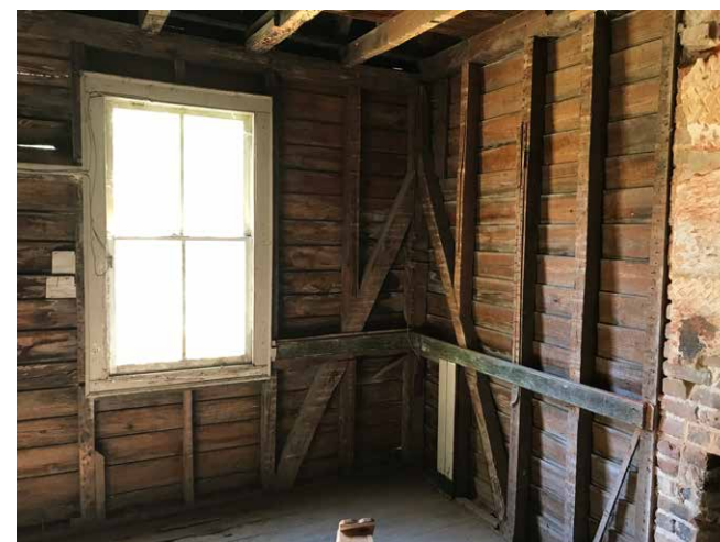
En typisk stolpverksvägg i husen på museet där ganska kläna dimensioner användes och där väggarna kläddes både invändigt och utvändigt, dock utan isolering imellan.
