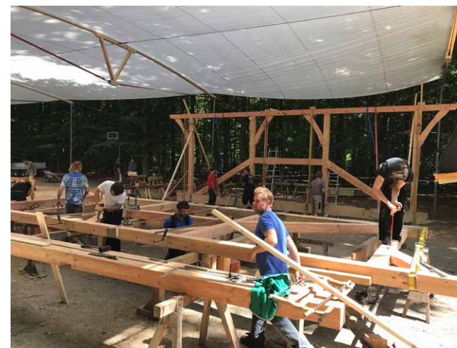
I bakgrunden har väggen rests upp och vi håller på att förbereda för ankarjärnen. I förgrunden håller andra väggen på att borrar för dymlingar och strävornas rundning huggs där på plats. Längst fram är Hannes Schnelle som är huvudmannen bakom Kesurokai projektet.
