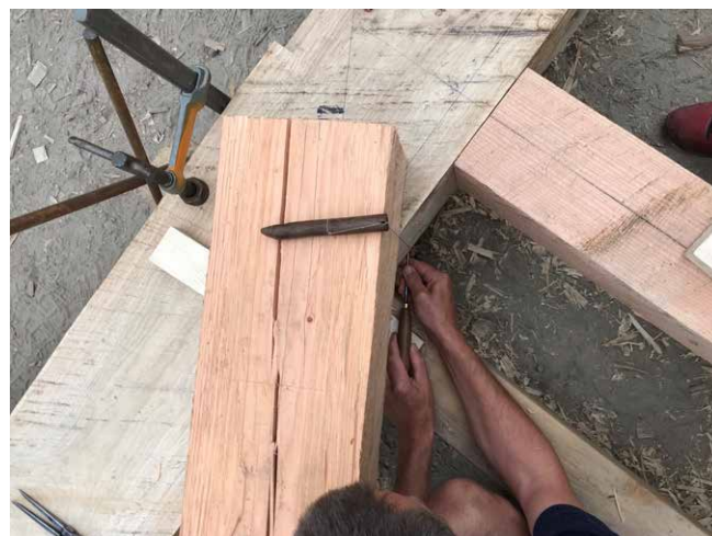
Joe Thompson håller på att föra över formen från bock-strävan till syllen med hjälp av lodsnoet som referens.
