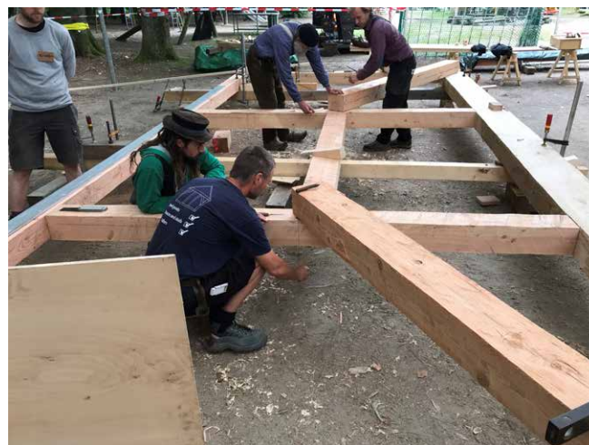
Den övre förbindningen i bocken passas in och här syns upplägget med vattenpass och lodet.
