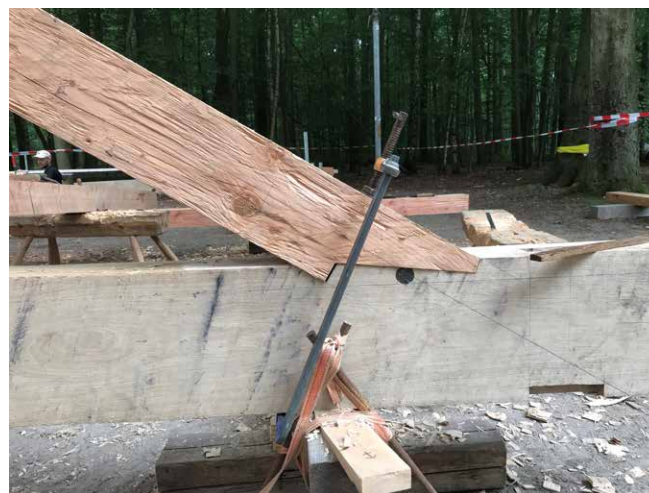
Ulriks "panna-häl" förbindningen, där de 5 mm hade sparats vid hälen, och där ett referenspunkt finns på centerlinjen på båda strävan och syllen med 2 fots avstånd (two-foot-marks)
