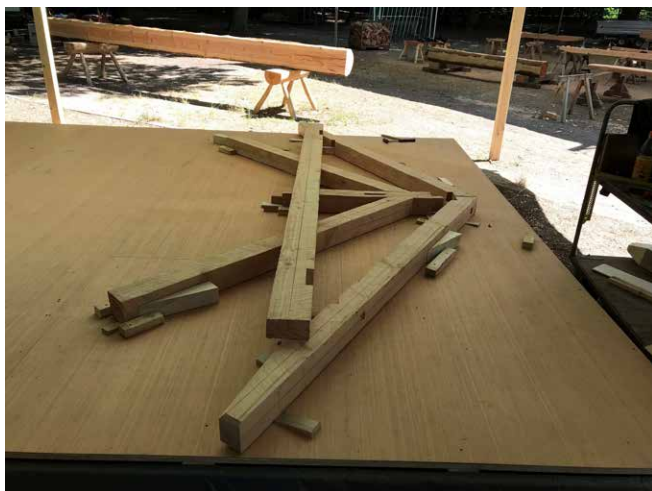
Tvärväggen lades tillbaka på utslagsgolvet efter linjerna och de två horisontella bindbjälkarna ritades på med krysskamning.
