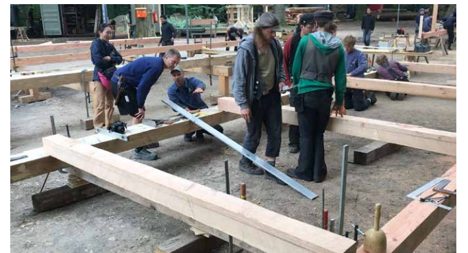
Långväggen i fullskaligt layout, där stolparna ligger ovanpå syllarna och där Johan Jönsson diskuterar med Joe Thomson och där Benjamin Börjesson håller på med en förbindning i bakgrunden. Här syns också referenslinjen på stolparna som ligger 5 cm från framsidan där tapphålerna kommer att vara.
