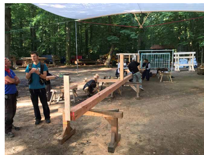
Den japanska delegationen håller på mednockåsen och passar in alla hängande kungstolper med de längsgående strävor.
