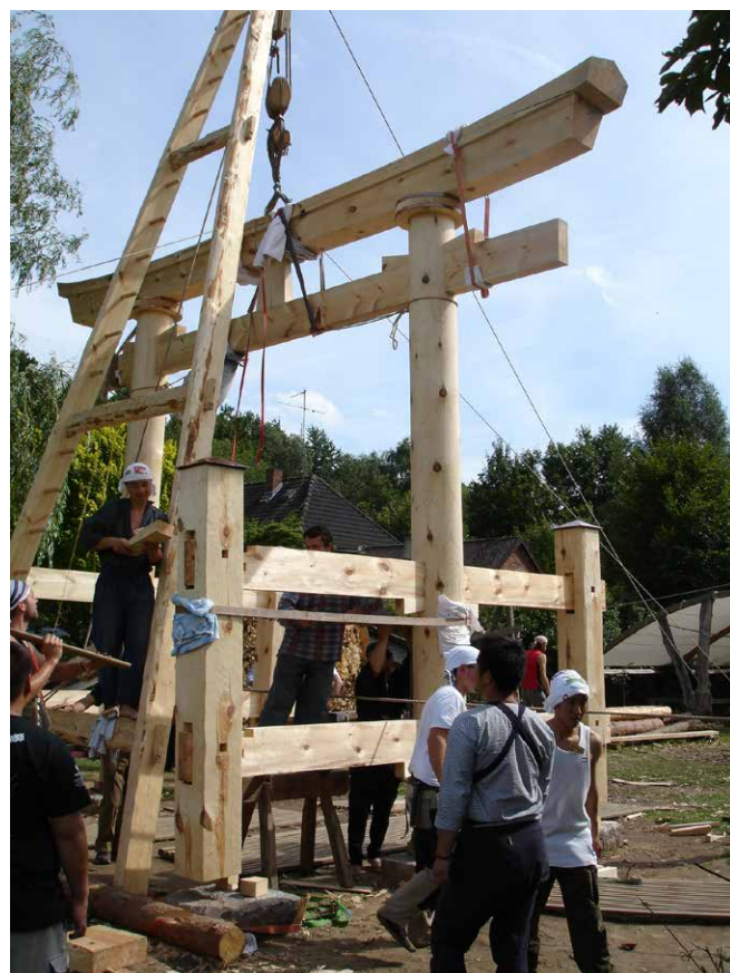
Resningen av Torii-konstruktionen i 2007
