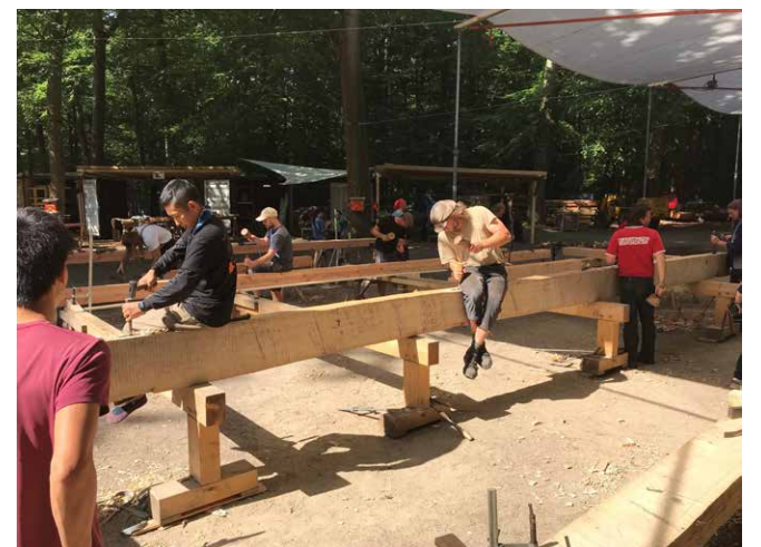
Syllen och remstycket på den andra väggen är påritat och har nu vänts för att hugga tapphålerna med en person för varje hål. Kristoffer Frederiksen och Magnus Jacobsson hugger i remstycket. I bakgrunden syns taken för smedjan och utslagsgolvet.
