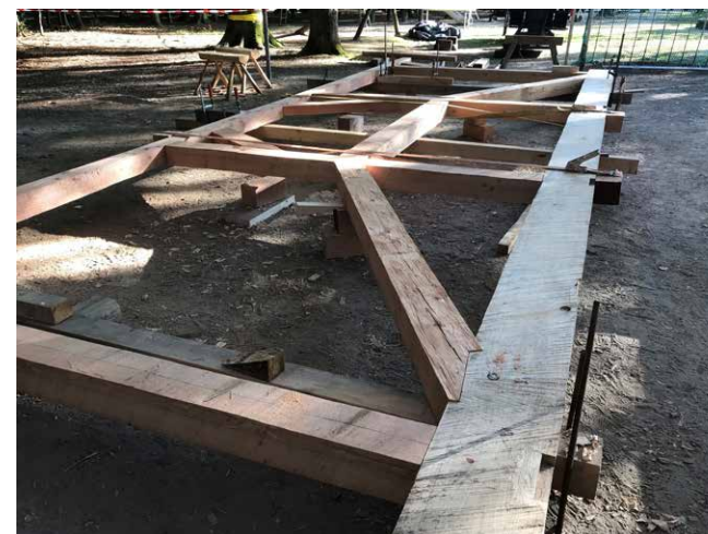
Långväggen samlat med strävor och bock och ihopdragen med spännband.
