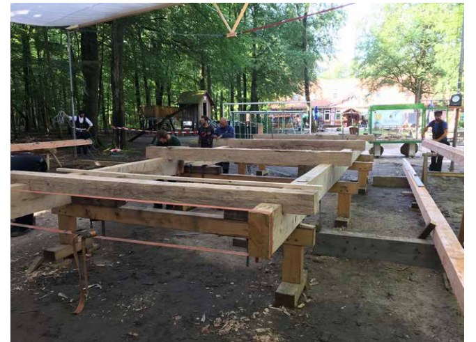
De två stora 6x10 tums ekbjälkar i syllvarvet hade en så pass stor böj att det var nödvändigt att hålla ihop dem med spännband vid påritningen. Här är de 4 tvärgående eksyllar kammade ned i de längsgående där man ser de olika höjderna.
