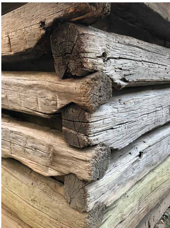
En typisk knuttimrat konstruktion, där man inte haft tid eller kunskap till att göra ett långdrag, och där det för bostadshus handlade om att använda lera som tätningsmaterial.
