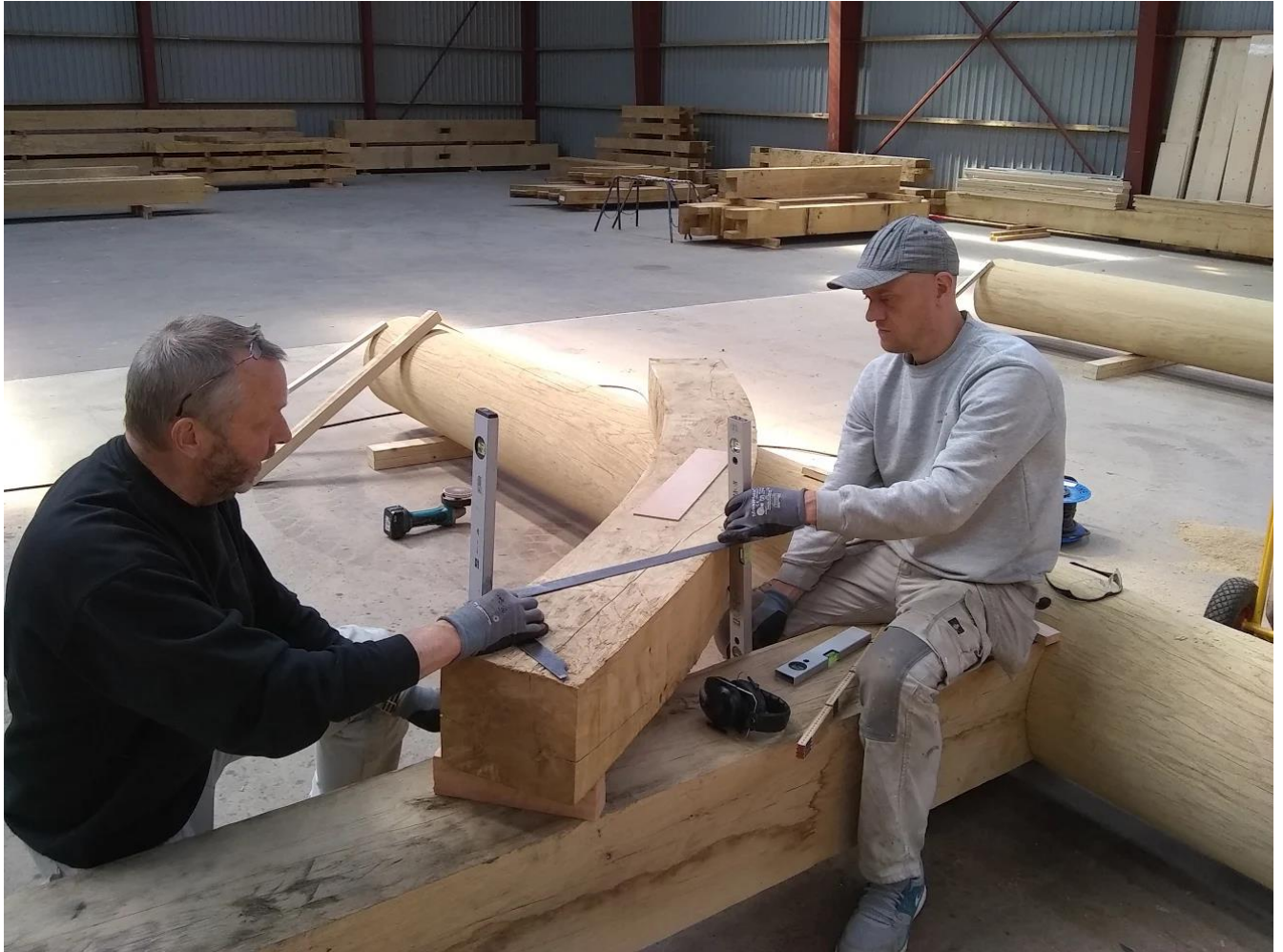
Opsnøring af kopbånd med loddestokke.
