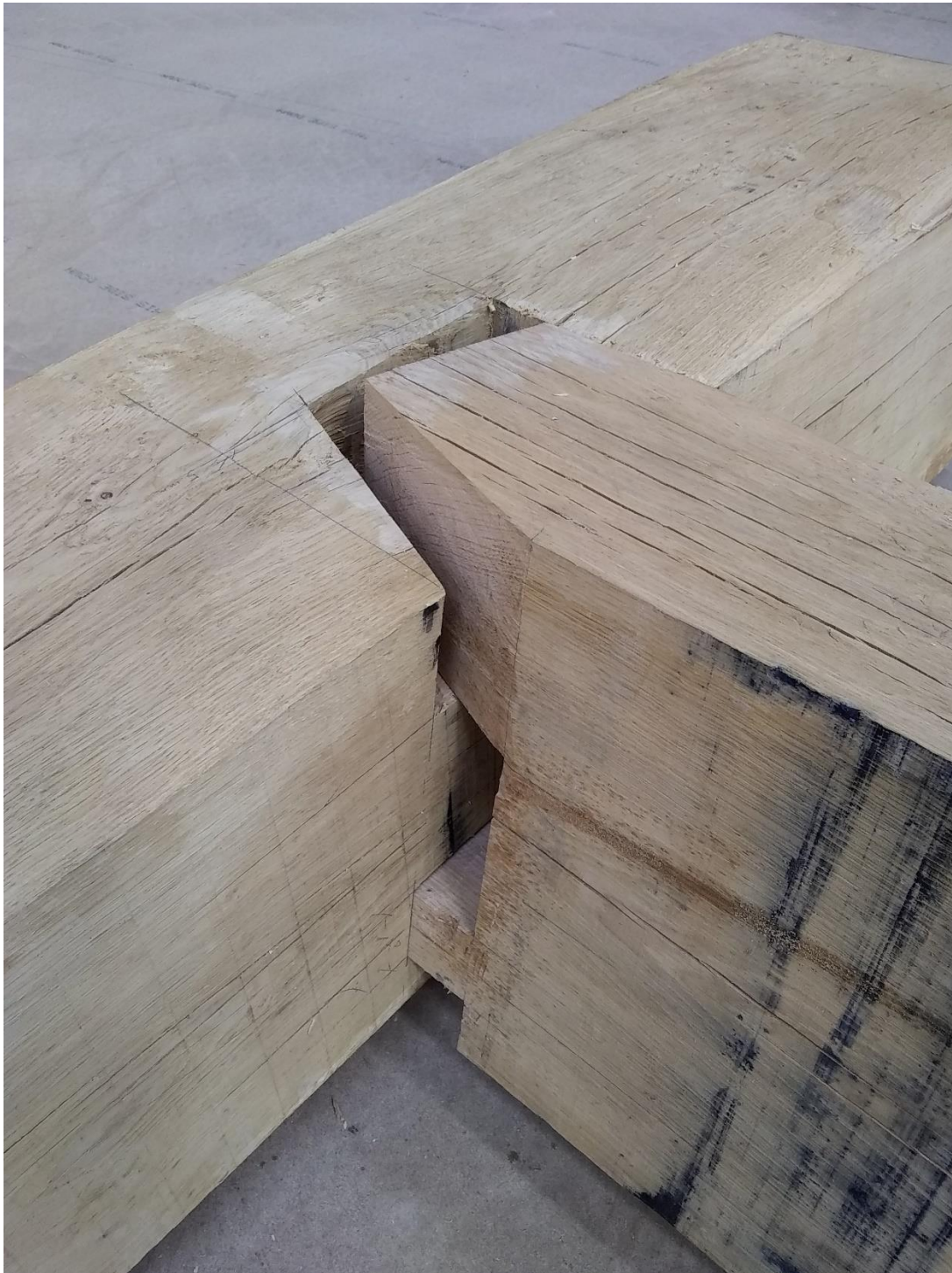
Samlingerne, hver især gennemprøvede i 3D-belastningssimuleringer af A/S Eduard Troelsgård rådgivende ingeniører, er mestendels naglede og kilede tap/taphuls-samlinger med to, tre og fire tommer brede tapper. Her et eksempel på en mere kompliceret samling – vinklet forbindelse mellem stikbjælke og hjørnestolpe.
