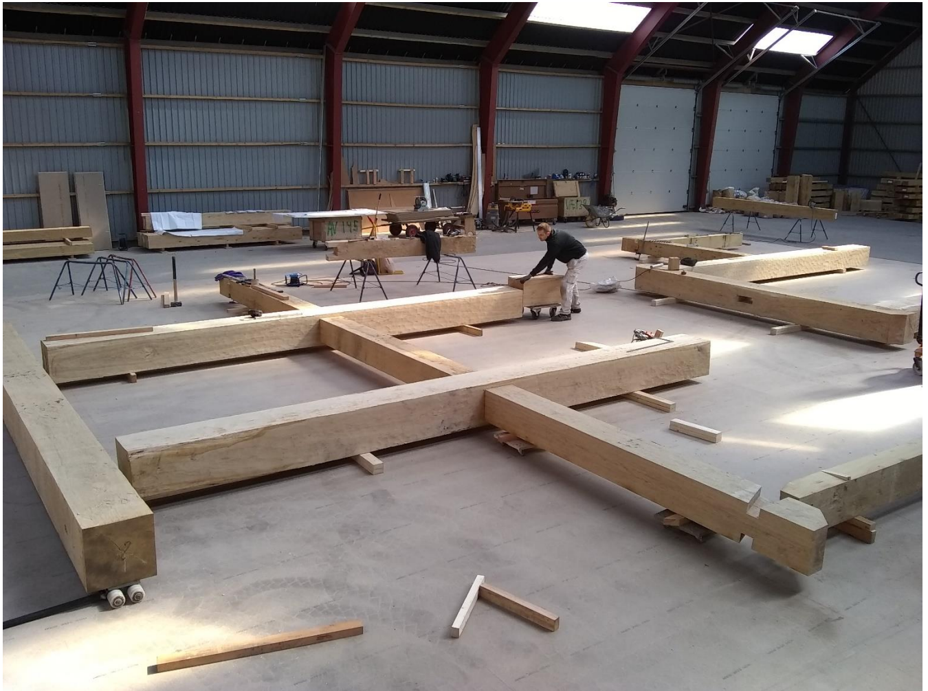
Fire tømrere – tre hos hovedentreprenøren og jeg selv – tilvirker stykkerne på et gulv med tilstrækkelig længde til at vi har kunnet lave en sammenhængende opsnøring af halvdelen af hallens plan.
