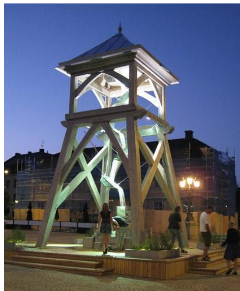
Öppen stolpverkskonstruktion, Järna bjälklag AB. Foto: Johannes Kästel
