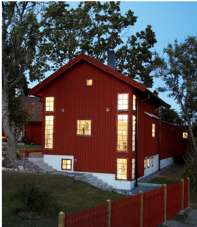
Inklädd stolpverksstomme, byggt av Järna Bjälklag AB. Foto: Stellan Herner
