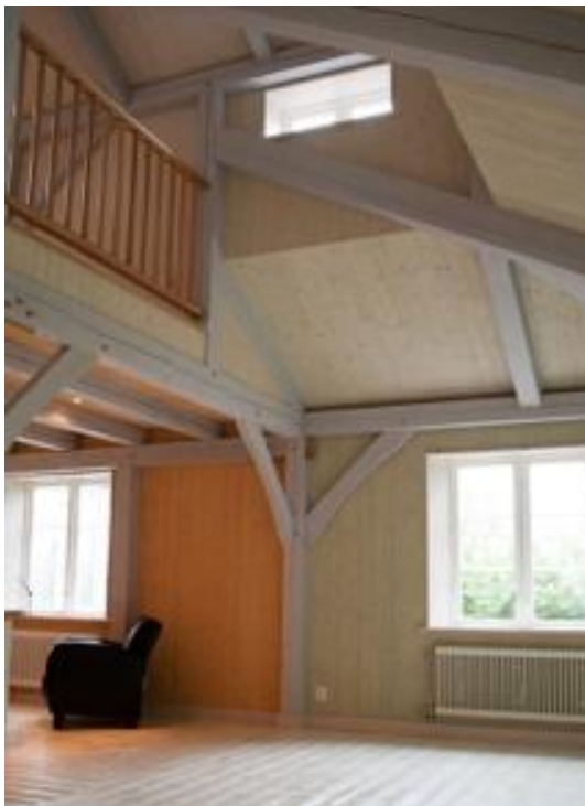
Bostadshus byggt av Järna Bjälklag AB. Foto: Johannes Kästel
